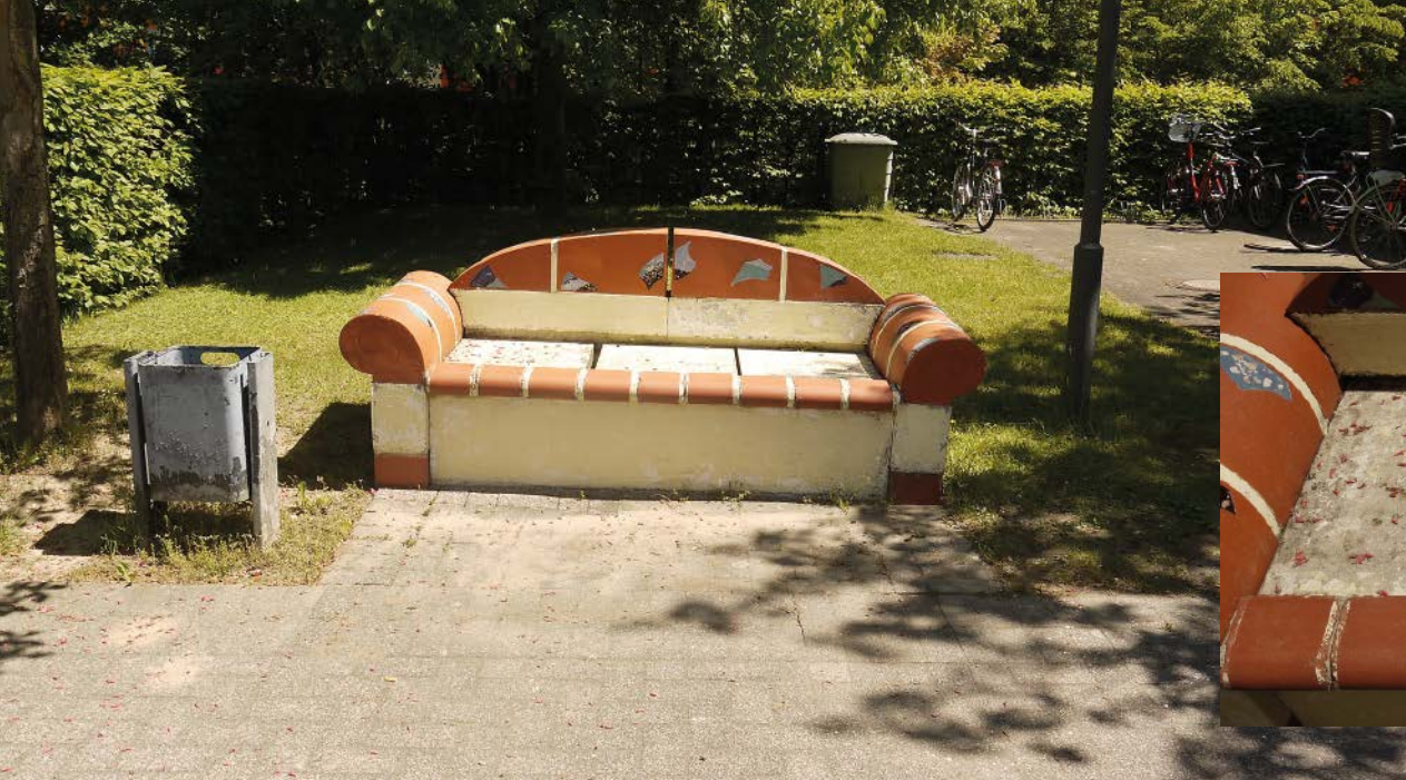
Eine Ruhebänk vor einer Altenpflegeeinrichtung im Land Brandenburg, die nicht genutzt werden kann, da sie gravierende Mängel aufweist.
