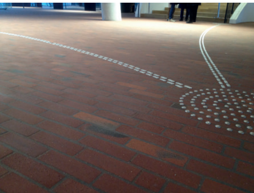
Fehlender Sichtkontakt zum Boden erschwert Älteren die Bewegung. Schneller stolpern sie und erleiden oft schwere Verletzungen. Im Bild: Ein Band für Blinde, bestehend aus leichten Erhebungen auf dem Fußboden (Elbphilharmonie, Hamburg)
